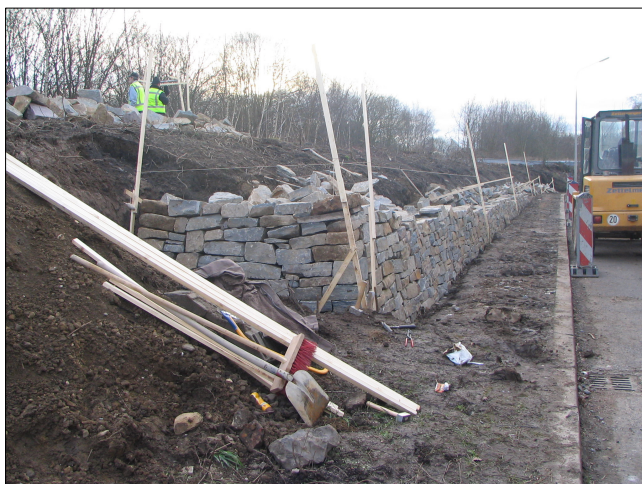
Fig. 6.4 Aanleg stapelmuurtjes voor hagedissen in het project spoorlijn Maastricht-Lanaken: een voorbeeld van een mitigerende maatregel voor de ecosystemendienst habitat van soorten 50 .
