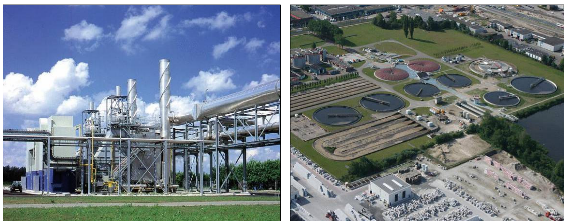
Fig. 3.13 Elektriciteitscentrale (links) en rioolwaterzuiveringsinstallatie (rechts)
