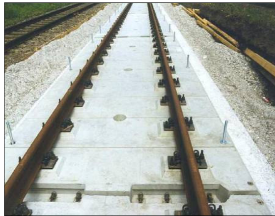
Fig. 3.17 Traditioneel spoor 26 (links) en een platenspoor van betonelementen (Duitsland) 27
